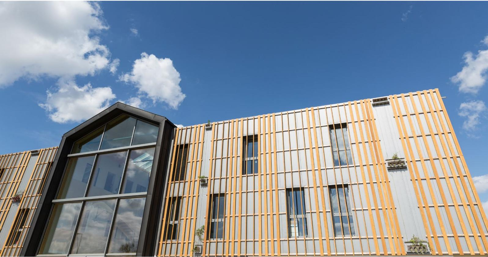
La façade reprend les codes couleurs du projet Convivium (gris, noir). Ces couleurs permettent de marquer les volumes dissociés de l'architecture. Sur le devant, un bardage bois ajouré est mis en place au dessus d'un bardage métallique micro-nervuré permettant d'amener une couleur grise derrière le bois.
