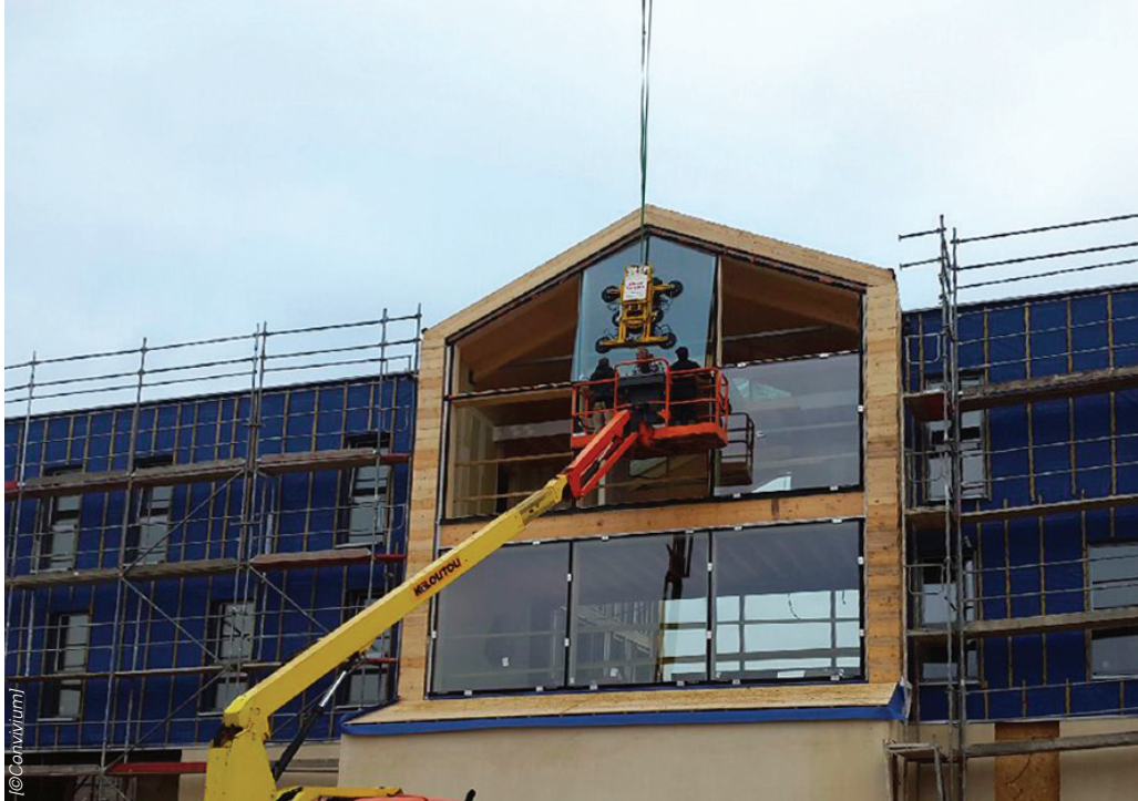
Sur l'ossature bois, la façade a été parée d'un pare-pluie.
