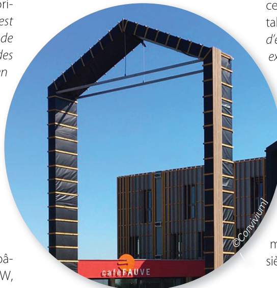
L'arche, qui reprend la forme de la baie vitrée, est couverte de bardage bois pour accueillir les visiteurs. Ici, en cours de pose.
