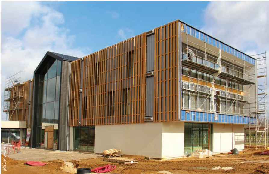
Le calepinage du bardage bois et de la future végétalisation a dû être mené avec une extrême précision.
